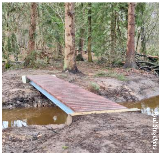
In februari werd de nieuwe brug geplaatst en kon het rode wandelpad opnieuw belopen worden.
